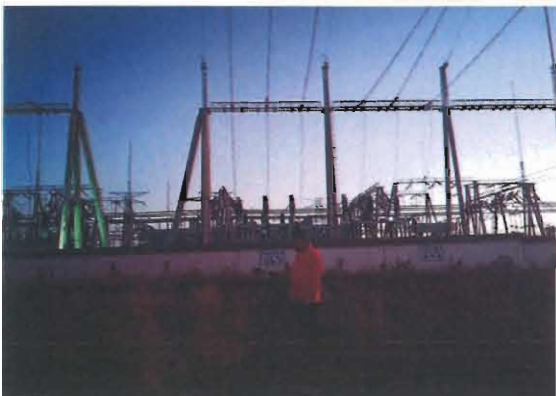
永兴 220kV 变电站间隔扩建处
