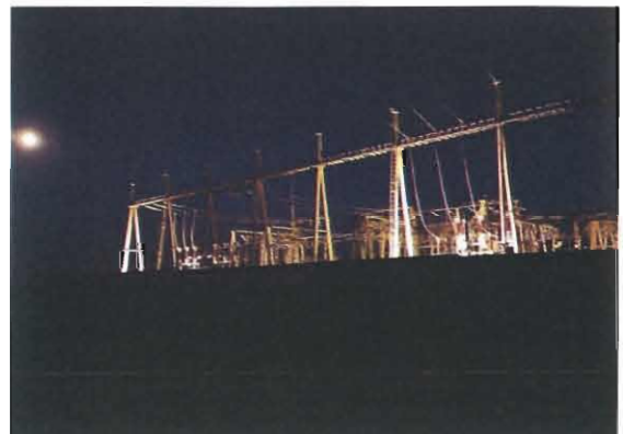
永兴 220kV 变电站间隔扩建处
