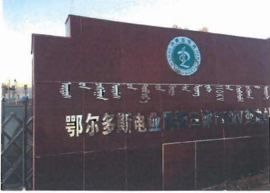
郭三梁 110kV 变电站
