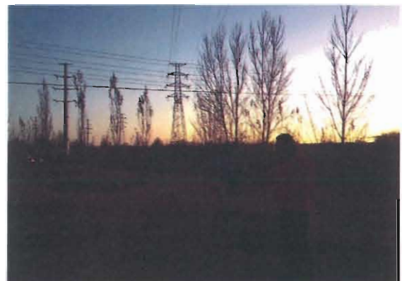
45#-46#塔兴梁 II 线
